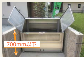
例外② ブロックの高さが700mm以下
